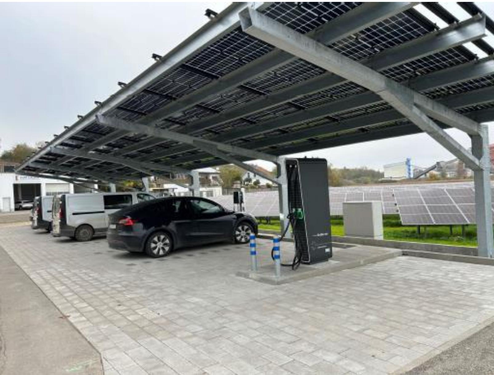
Bild (T.Werk; A5.260): L-Trägersystem mit Einlegemodulen als Dachlösung
