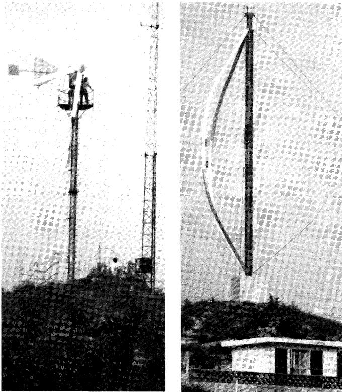
Neueste Ergebnisse des Engagements der Firma Dornier in der Volksrepublik China. Beide Windkraftanlagen wurden in der Nähe von Beijing ausgestellt und speisen in das Elektrizitätsnetz ein. Die Anlage im rechten Bild leistet 30 kW.
