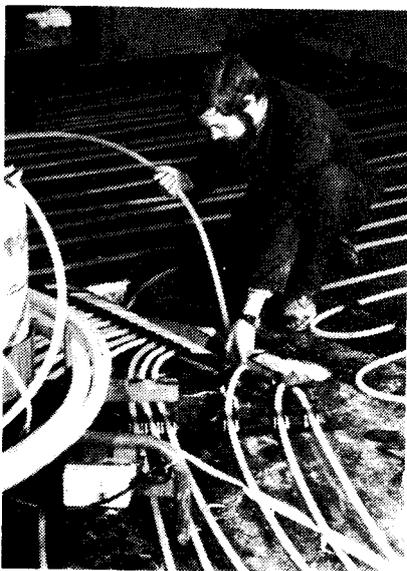
Bild 4: Verlegen der Schlauchrohre der Multibeton-Fußbodenheizung
