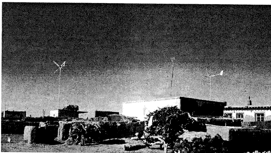
Abb. 3: Das Dorf Yingen in der Inneren Mongolei. Stromversorgung durch zwei Windräder Inventus 6 (5 kW) von WENUS, Erfstadt
