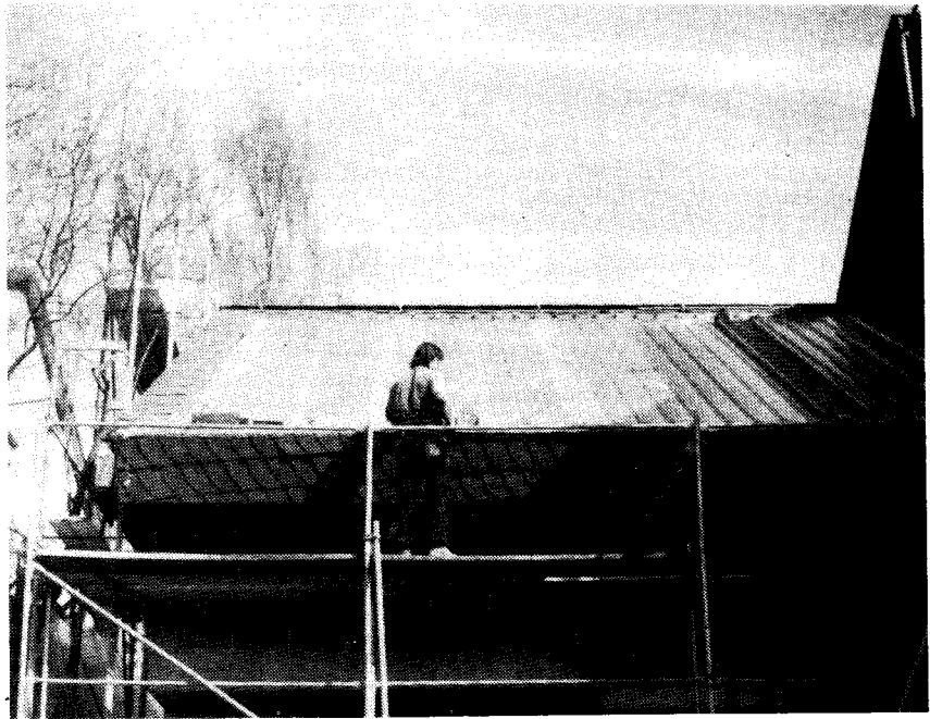
Bild 3: Nach einer knappen Stunde ist der Einbau abgeschlossen
