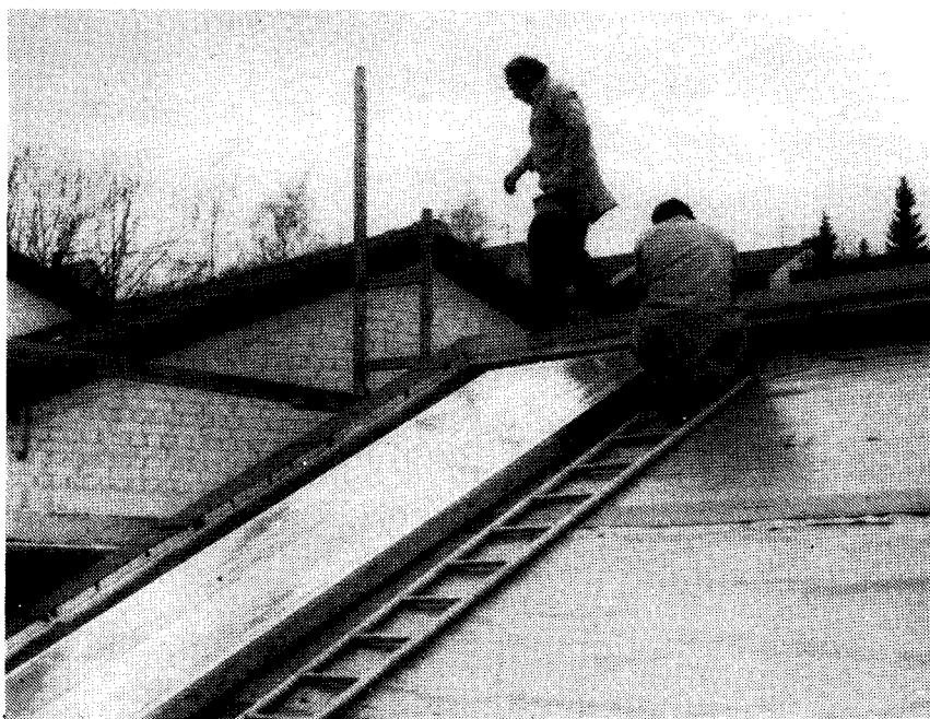
Bild 2: Ausrichten in der Dachwanne
