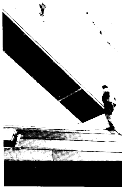
Bild 1: Einbringen des Kollektors in das Solardach
