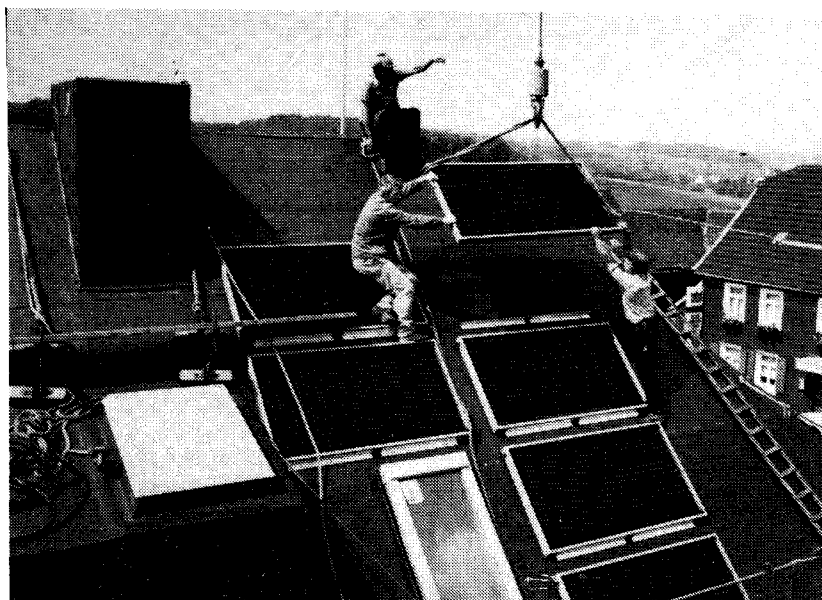
Bild 1: Im Juni 1975 wurden die Kollektoren auf dem Süddach des Neubaus installiert Aufn.: G. Jagenburg
