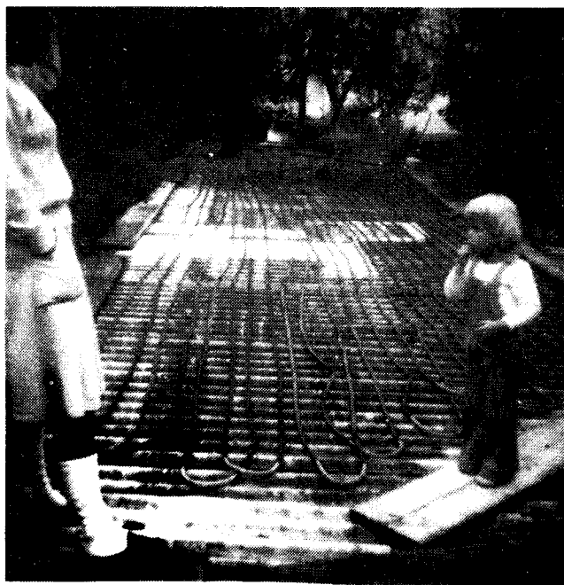
Bild 2: Hier sind die Schläuche ohne jeden ästhetischen Anspruch einfach auf das falsche Eternitdach eines Schupfens gelegt. Die engen Krümmungen sind mit Gartenschlauch gestückt; dies ist jedoch nicht notwendig, wenn der PVC-Schlauch in einer sauberen Spirale aufgelegt ist
