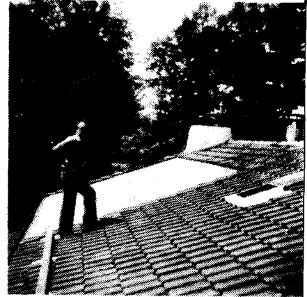
Bild 1: Der mit Doppelstegplatten aus Plexiglas abgedeckte Kollektor von Josef Andre ist in die Dachfläche integriert. Aufn. Urbanek
