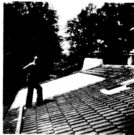
Bild 1: Der mit Doppelstegplatten aus Plexiglas abgedeckte Kollektor von Josef Andre ist in die Dachfläche integriert. Aufn. Urbanek
