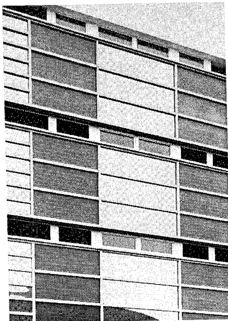
Abb. 2: Kollektorfassade von Schweizer Foto: SUNTEC
