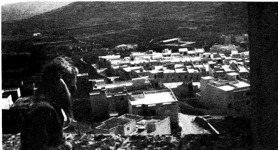
Bild 7. Auf den flachen Hausdächern installiert man zweckmäßigerweise waagrecht zu verlegende Kollektoren. Das Bild entstand auf der Nachbarinsel Malta, Gozo.
