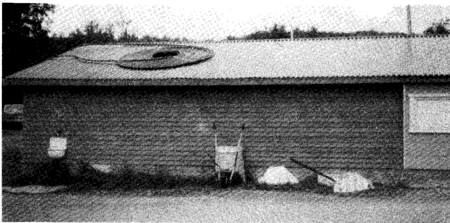
Dieses Bild zeigt möglicherweise Europas nördlichste selbstgebaute Solaranlage. Michel Voss aus Ertstadt-Friesheim entdeckte sie auf seiner Fahrradtour durch Skandinavien auf dem Campingplatz von Russenes in Norwegen 400 km nördlich des Polarkreises. Auf dem schwarzen Wellblechdach des Toiletten- und Waschgebäudes liegt zusammengerollt ein schwarzer Schlauch, über den Sonnenenergie zur Vorwärmung des Duschwassers eingefangen wird.
