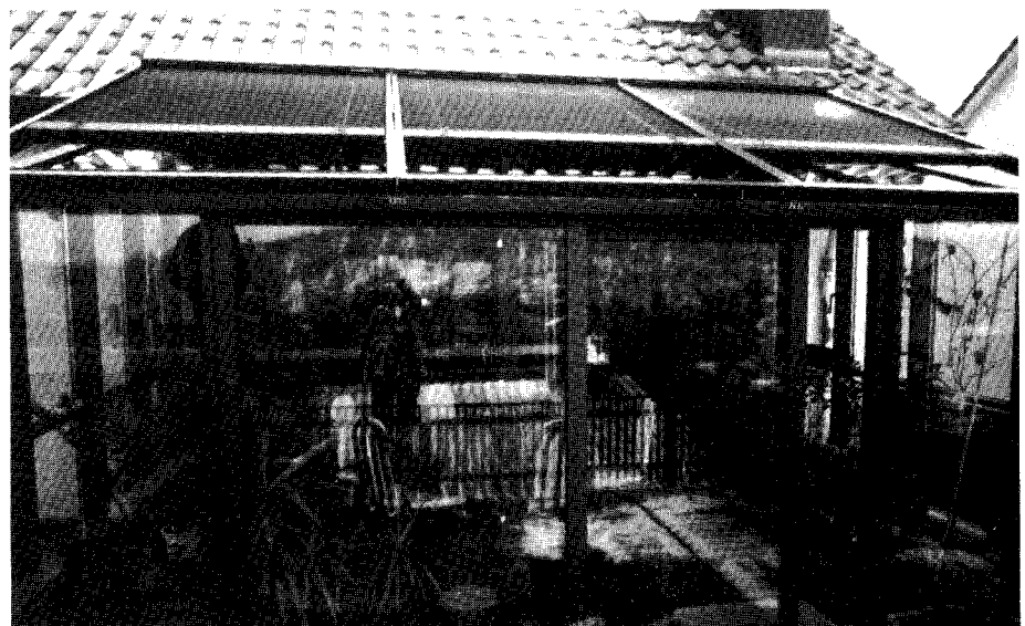
Wintergarten, aufgebaut aus Aluminiumprofilen des eigens dafür entwickelten Systems der BUG-Alutechnik
