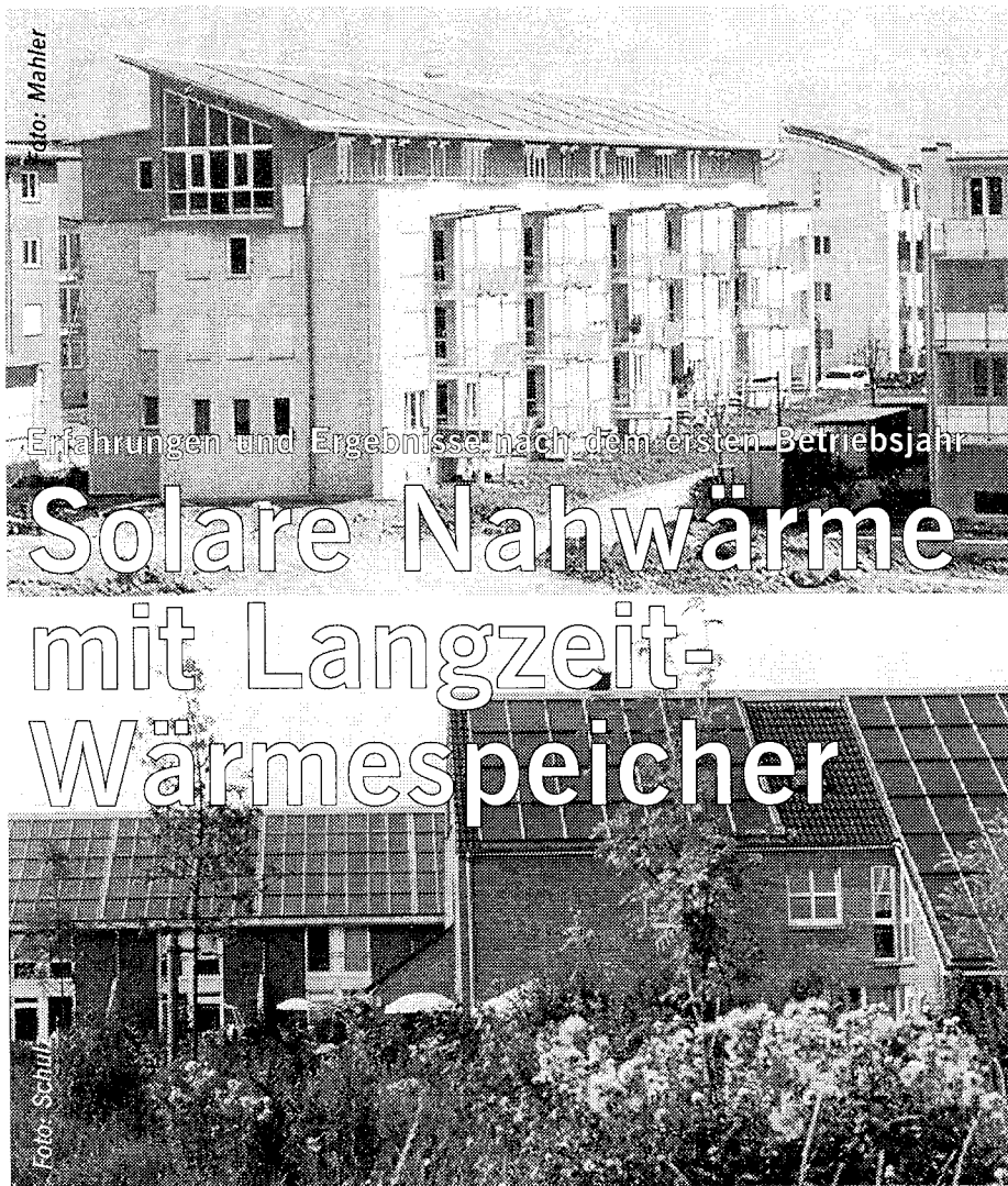
Die Pilotanlagen zur solaren Nahwärmeversorgung mit saisonaler Wärmespeicherung in Friedrichshafen-Wiggenhausen (oben) und Hamburg-Bramfeld (unten) wurden vom Institut für Thermodynamik und Wärmetechnik (ITW) der Universität Stuttgart initiiert und über die gesamte bisherige Laufzeit wissenschaftlich begleitet. In diesem Bericht werden wesentliche Erkenntnisse aus dem Bau und dem Betrieb der beiden Anlagen im ersten Jahr wiedergegeben.
