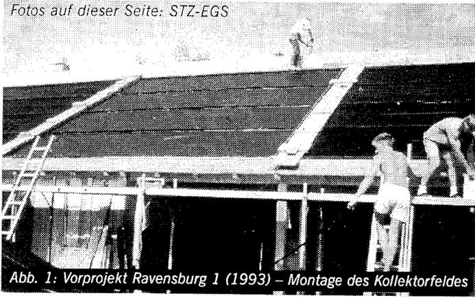
Abb. 1: Vorprojekt Ravensburg 1 (1993) – Montage des Kollektorfeldes
