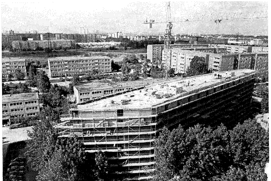
Abb. 2: Das Niedrigenergiehaus während der Bauphase
