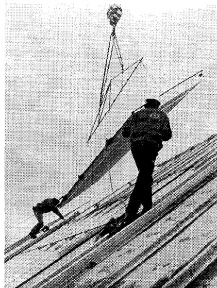
Abb. 1: Montage der Kollektoren
