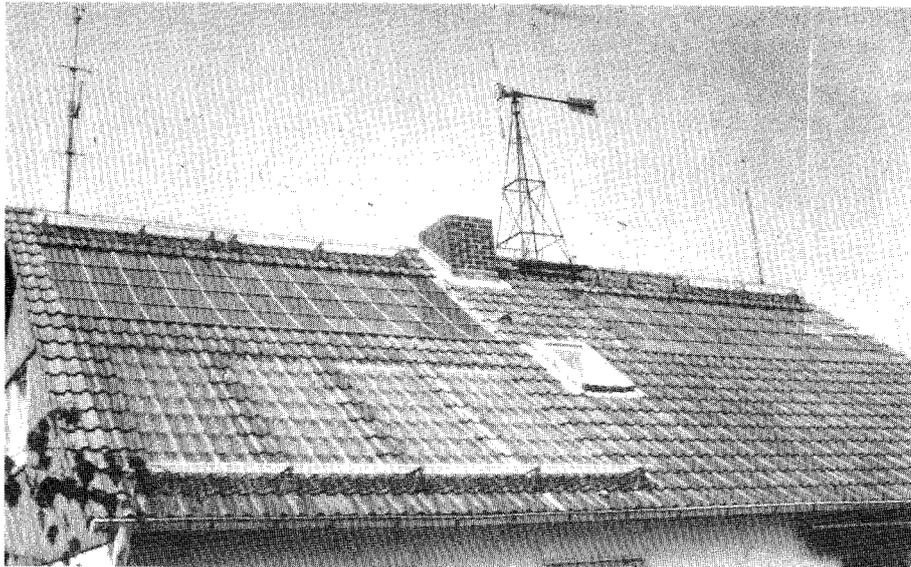
Ansicht des Büro- und Wohnhauses in Langenselbold (oben: zwei Photovoltaikfelder mit einer Gesamt-Nennleistung von 1,84 kW; unten: Thermosiphon Sonnenkollektoranlage, 7,5 m<sup>2</sup>; Dachfirst: kleine Veruchs-Windkraftanlage 50 – 200 W)
