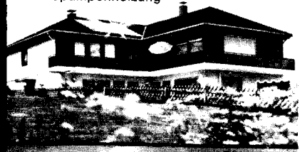
Riwa-Haus mit Sonnenkollektoren und Wärmepumpenheizung
