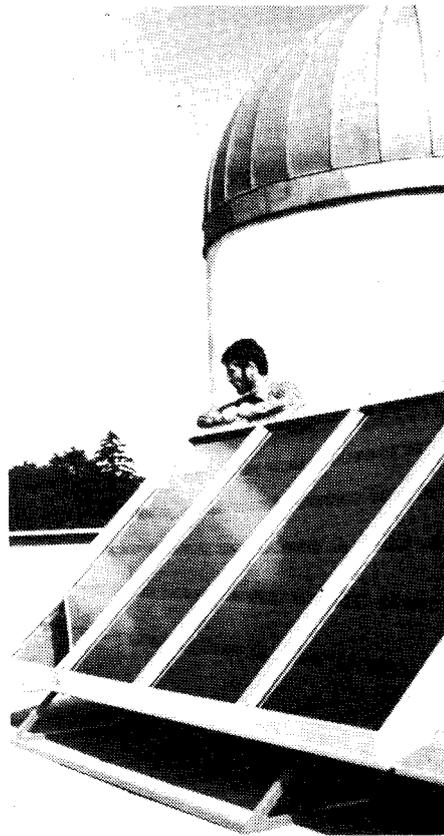
Bild 3: Die Sternwarte von Neumarkt/Oberpfalz wird durch Luftkollektoren beheizt
