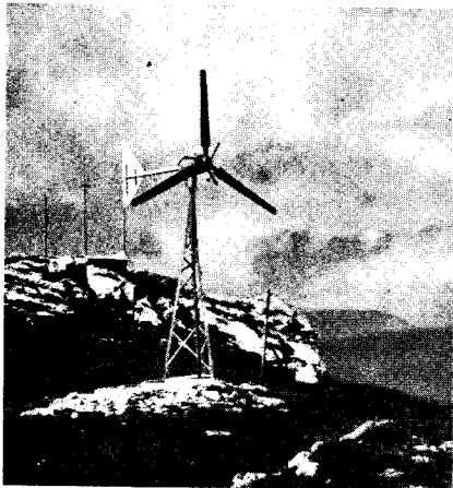
Bild 1: Die Stromversorgung für ein Bergrestaurant übernimmt dieser 5-kW-Windenergiekonverter
