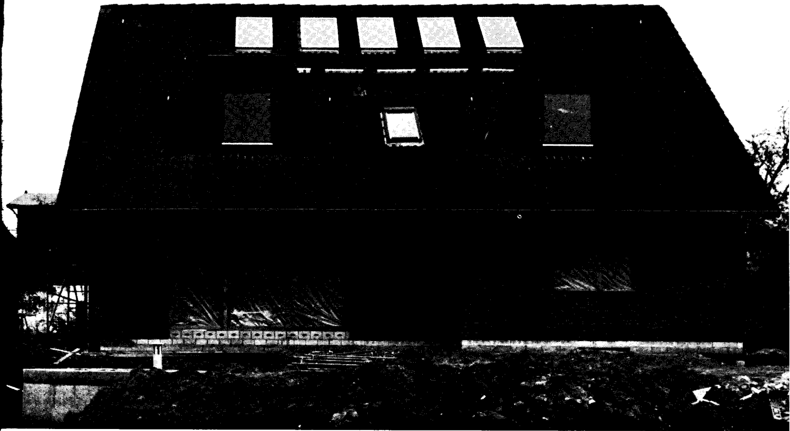
Solare Brauchwassererwärmung in einem Einfamilienhaus in Flensburg (Bericht Seite 18)
