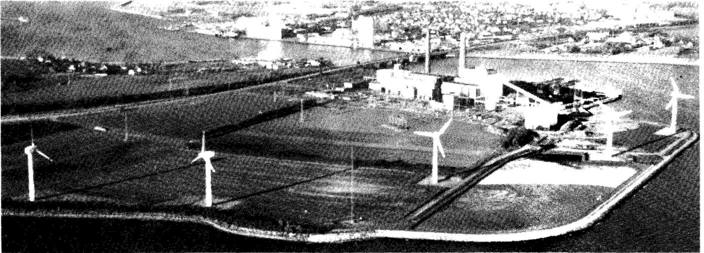
Kürzlich in Betrieb genommener Windmühlenpark der Elektrizitätswerke von Südseeland (SEAS) auf dem Kraftwerksgelände Masnedø bei Vordingborg. Jährlich wird eine Stromlieferung von insgesamt 7,5 GWh erwartet.
