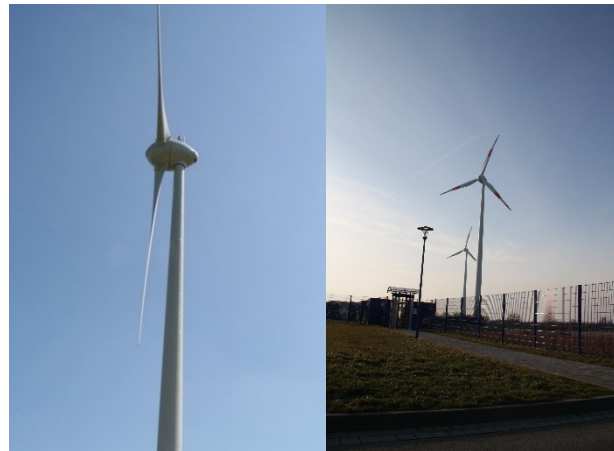
Windenergieanlage E-53 der ENERCON GmbH / Windenergieanlagen in einem Gewerbegebiet
