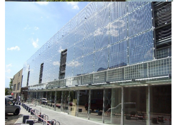
Photovoltaikanlagen von ertex solartechnik GmbH Österreich
