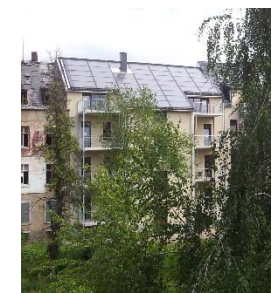
Hofansicht nach Sanierung
