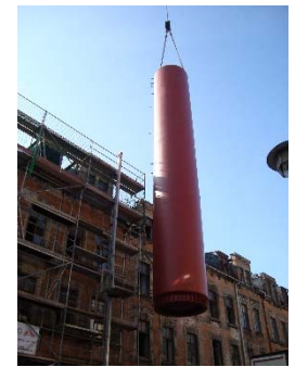
Strasse während Sanierung
