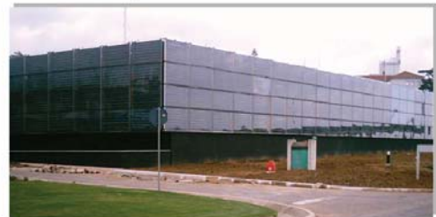
Centro Operacional da Brisa - Carcavelos
