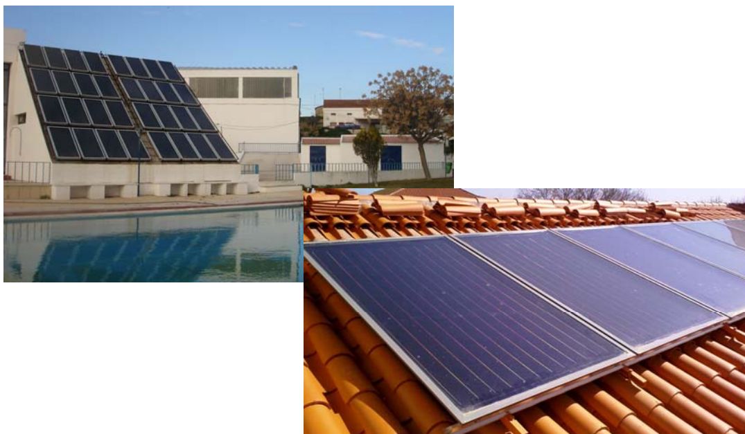
Fig.19 Colector plano montado num telhado
