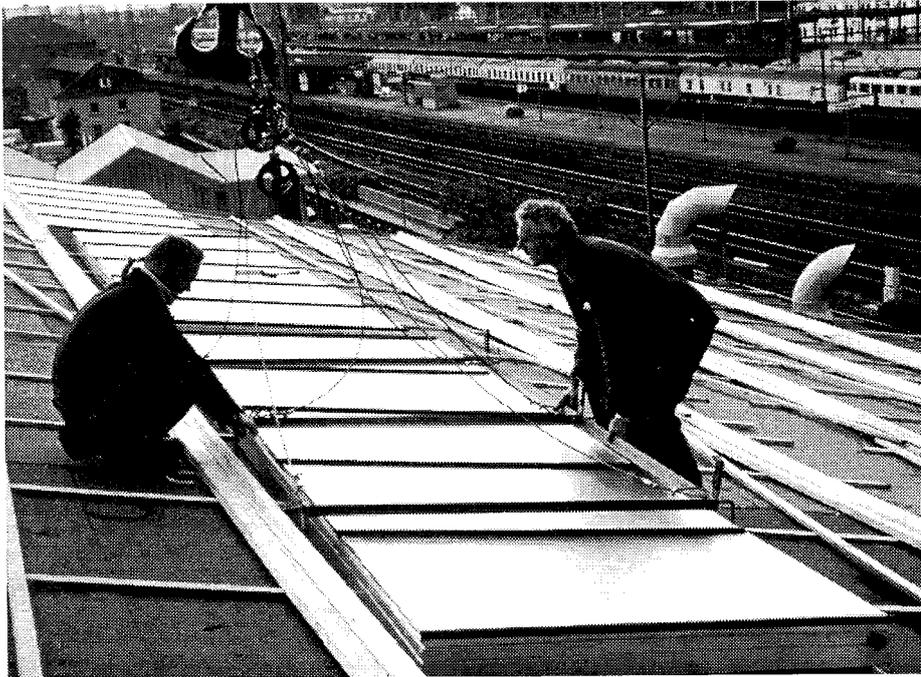
Abb. 3: Montage der Kollektormodule auf dem Süd- und Westdach des Göttinger Heizkraftwerks
