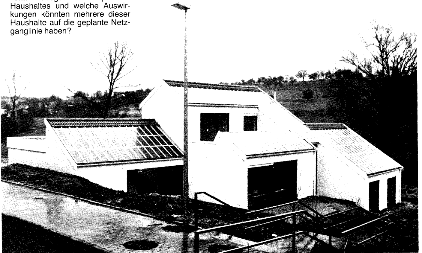
80 Quadratmeter Solarzellen auf dem „Sonnenhaus Ensheim“
