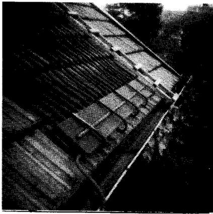
Bild 3: Seit 1966 in Betrieb ist diese Bastleranlage mit schwarzen PVC-Weichschläuchen auf einem Ziegeldach (hier mit einem provisorisch montierten Verteiler aus Aluminium)
