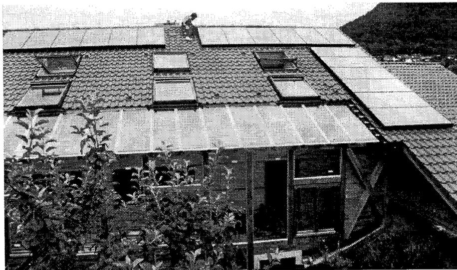
Abb. 2: Drei 12-m<sup>2</sup>-Kollektormodule auf einem Zweifamilien Haus 500 l Brauchwasserspeicher und 12.000 l Pufferspeicher. Fotos: AQUASOL
