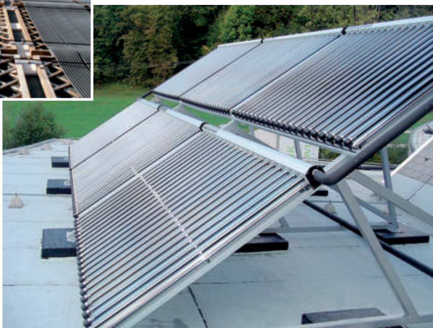
Vakuumski sprejemniki v Termah Snovik (Vir: Zarja Kovis d.o.o.)
