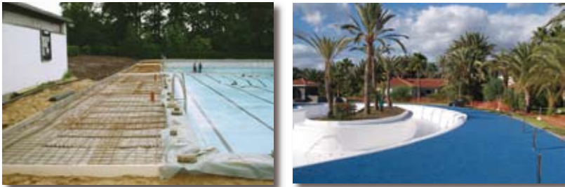
Abb. 14 Sport Solarabsorber, links Verlegung, rechts fertiger Bodenbelag mit eingebetteten Absorbern (Foto: SOLKAV)
