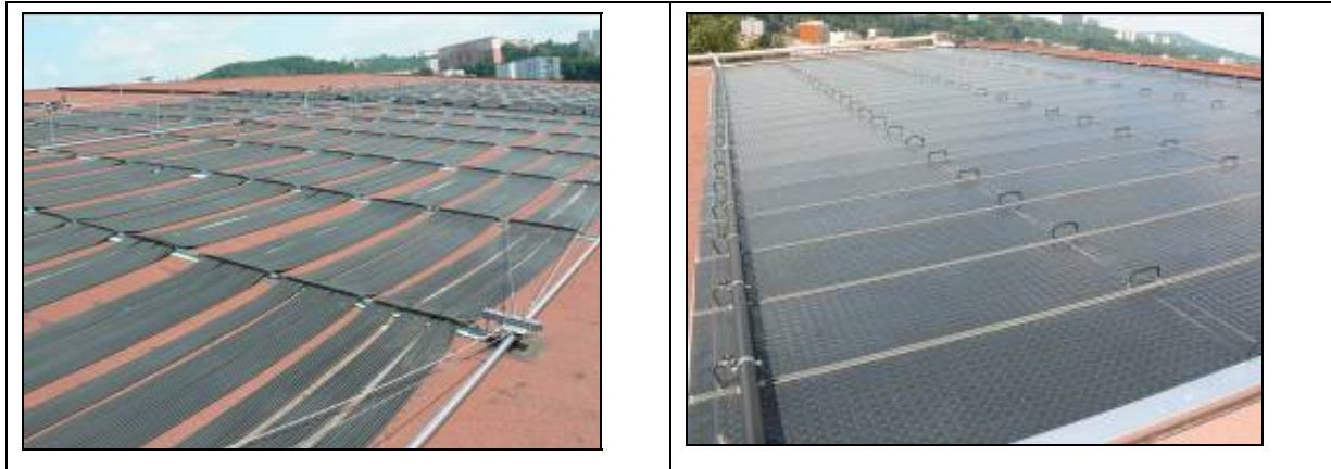
Figure 8: Piscine publique de Vaise à Lyon, France (Source: ALE)
