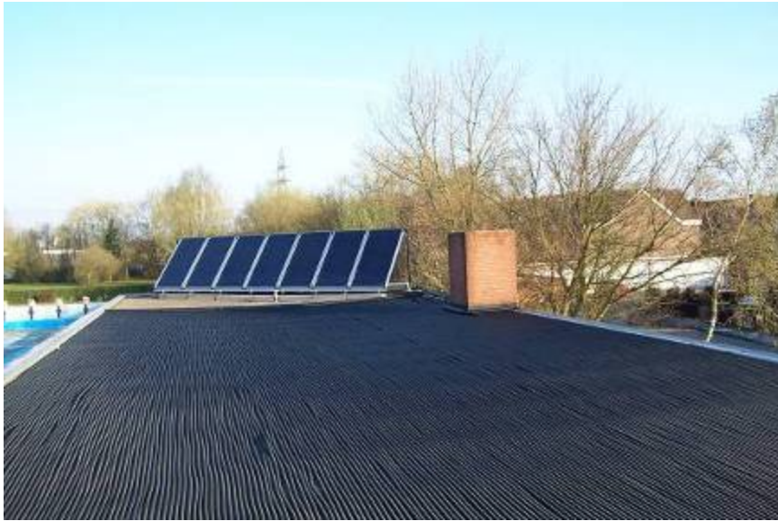
Figure 6: Combinaison de capteurs plans et de capteurs moquette (Allemagne)
