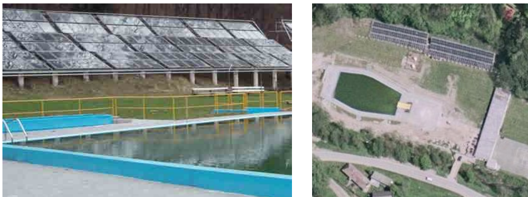
Obrázek 1: Koupaliště na Rusavě, vlevo část bazénu a západní část kolektorového pole(© Czech RE Agency, o.p.s.), vpravo satelitní snímek areálu, kolektorová pole v horní části (© www.geodis.cz, ©mapy.seznam.cz)
