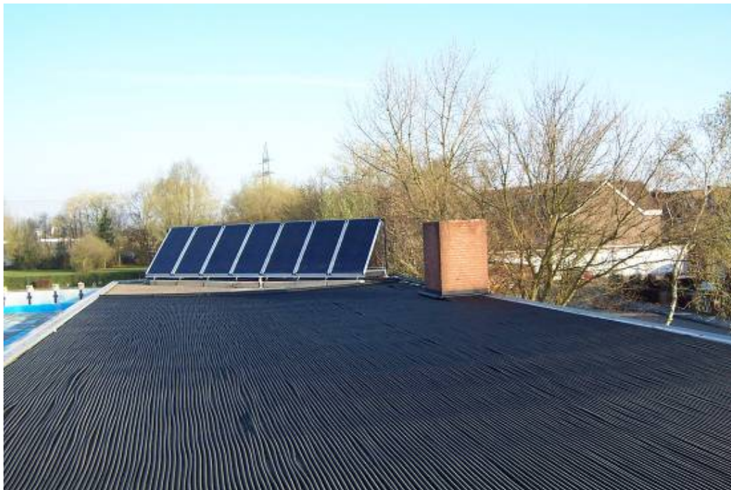
Abbildung 11: Absorber und Flachkollektor (Hybridnutzung) (DGS, 2008)
