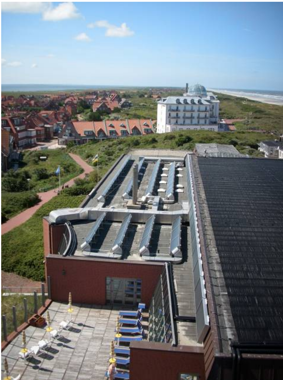
Abbildung 12: Kombination von Luftkollektoren und Kunststoffabsorbern (DGS, 2008)
