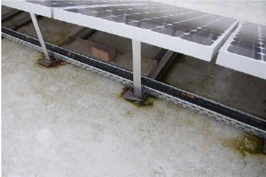
Absenkung der punktförmigen Auflager auf Kunststoffdach mit Wasseransammlung [AIBau]
