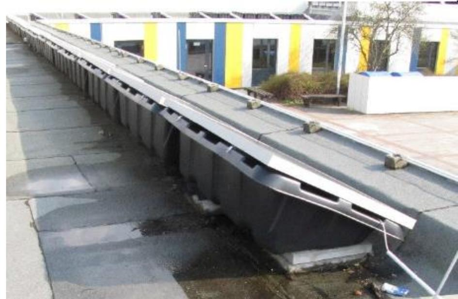
Absenkung der bei Wannensystemen auf Bitumdach mit Behinderung des Wasserablaufs [AIBau]
