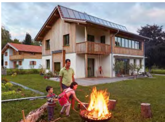
Sonnenhaus mit Stroh gedämmt und mit einem großen Speicher für die Solarthermie ausgestattet
