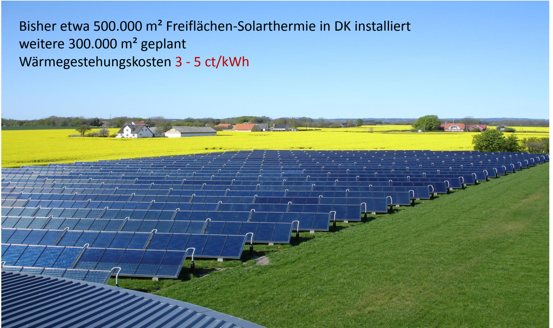
Foto: Arcon Solar A/S - Solare Fernwärme Ulsted
