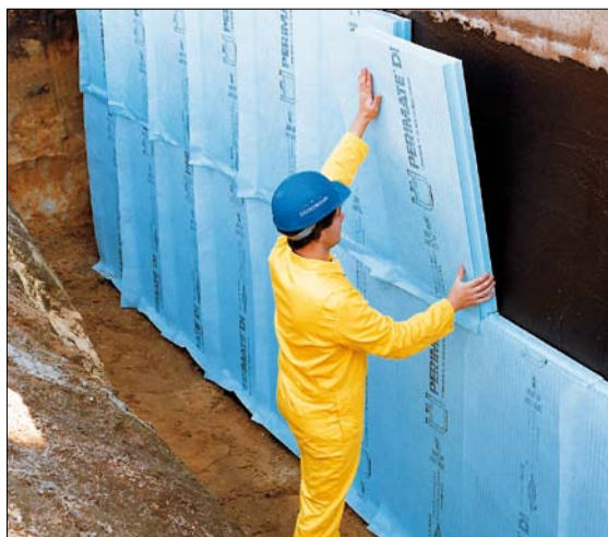
XPS-Dämmplatten zur Perimeterdämmung im Kellergeschoss
