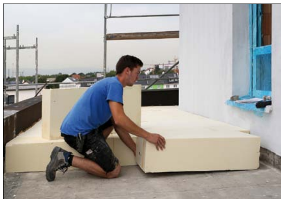
Flachdach-Dämmung mit einer hocheffizienten PUR/PIR-Platte
