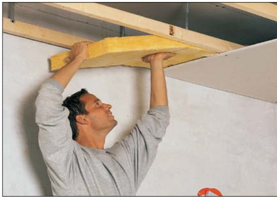
Einbau einer Glaswolle-Matte als Schalldämmung
