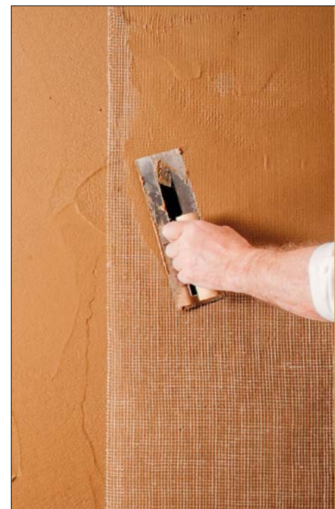
In den Lehmklebe- und Armierungsmörtel wird Glasgewebe eingearbeitet
