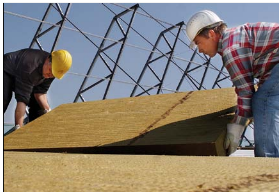
Mineralwolleplatten werden auf einem Flachdach verlegt
