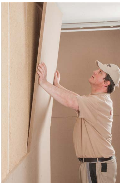
Zügiges Arbeiten beim Trockenbau mit Holzweichfaserplatten von 1,25 Metern Breite
