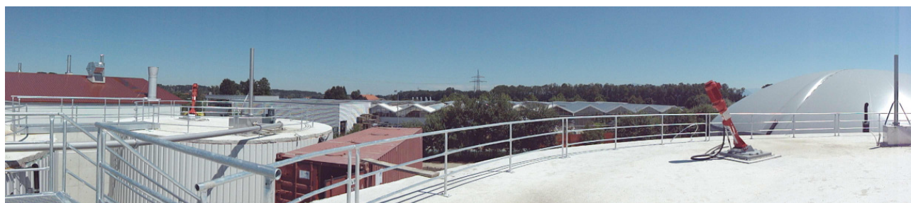
Ansicht Biogasanlage mit Gartencenter im Hintergrund
